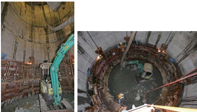
主立坑の坑底（深度467.1m）
